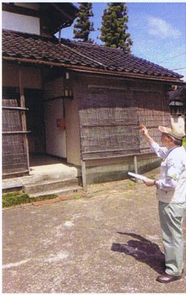
空き家を目視により異常がないか点検
